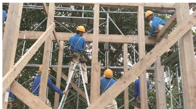
建て方作業に従事するミャンマー人実習生
