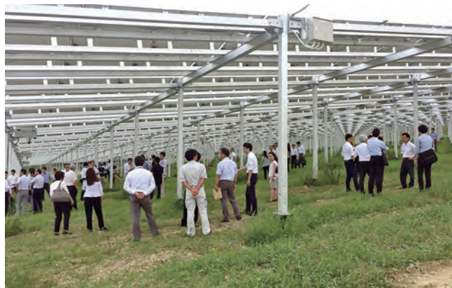
竣工後の発電所視察
